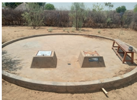
Eine Anlage zum Auffangen des Regenwassers
